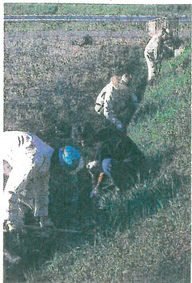
◎会員の皆さん◎水路清掃作業
